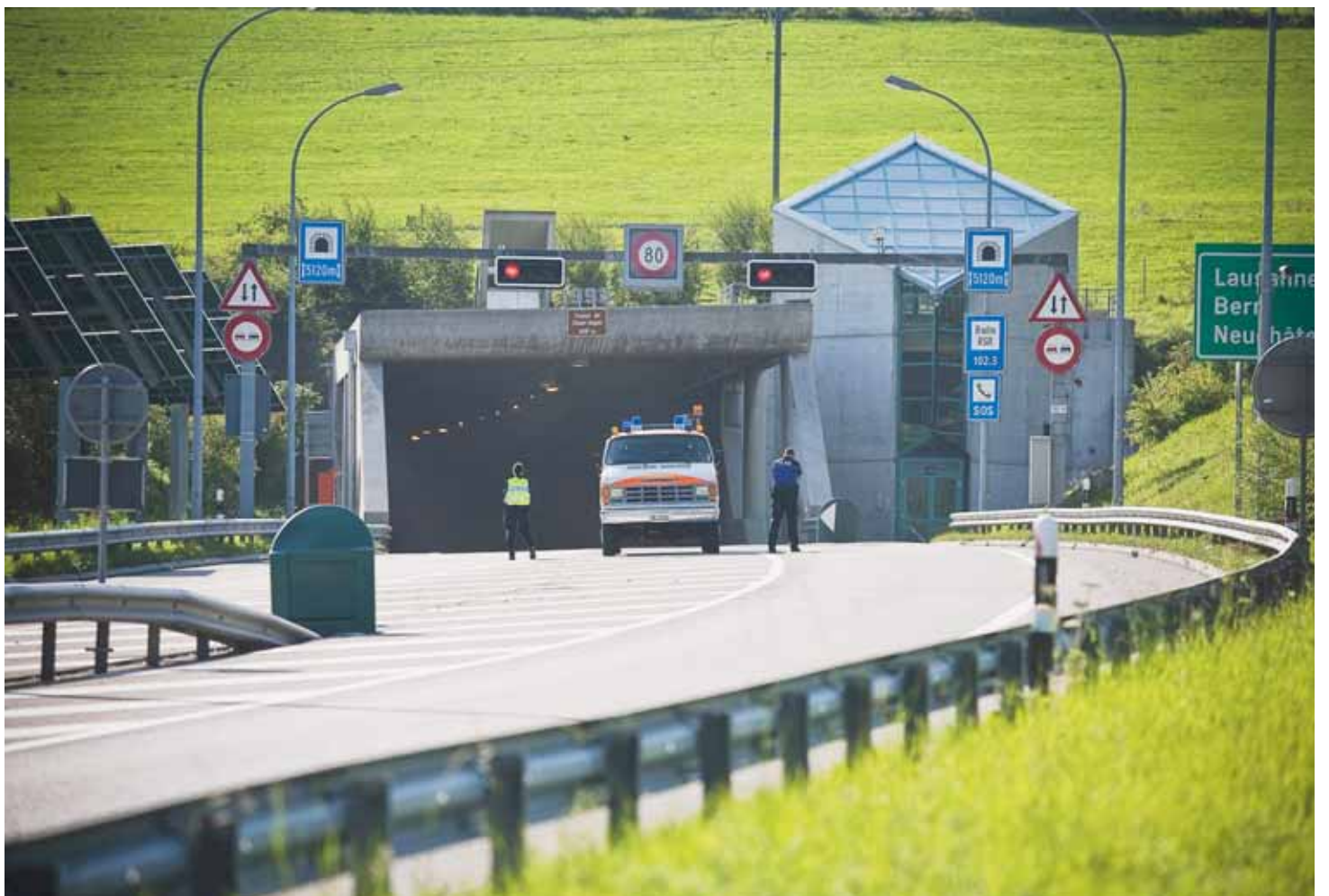
Le 1er septembre 2009, le tunnel sous La Vue-des-Alpes avait dû être fermé en raison d'un dégagement de fumée. ARCHIVES GUILLAUME PERRET
