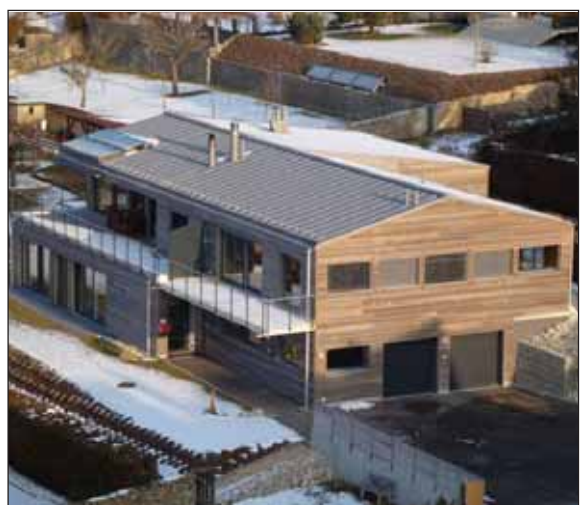
L'entreprise Eric Marti SA de Saint-Blaise a réalisé la toiture en zinc prépatiné de cette villa mitoyenne au style contemporain. sp-E
