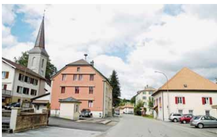
Le temple, la maison de commune (façade rouge) et le bâtiment de la poste pourraient être concernés par le projet. ARCHIVES DAVID MARCHON
