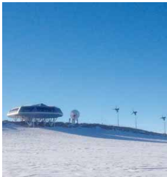
La station et quelques-unes des éoliennes.
