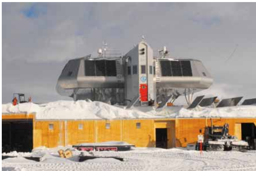
La station et, au-dessous, le garage des «Ratrac».
