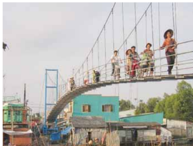
VIETNAM Province de Bac Lieu Dans le monde, plus d'un million de personnes utilisent un «pont Rüttimann». De 2005 à aujourd'hui, ces ponts représentent 670 tonnes de câbles, 1500 tonnes de tuyaux pour les piliers (en bleu) et 500 tonnes de plaques d'acier.
