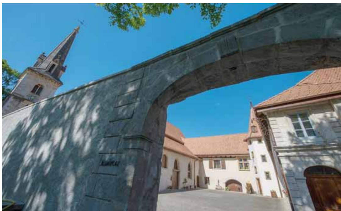
Le mur d'entrée a été rénové et un appentis, sans valeur historique et donnant sur la cour, a été supprimé.
