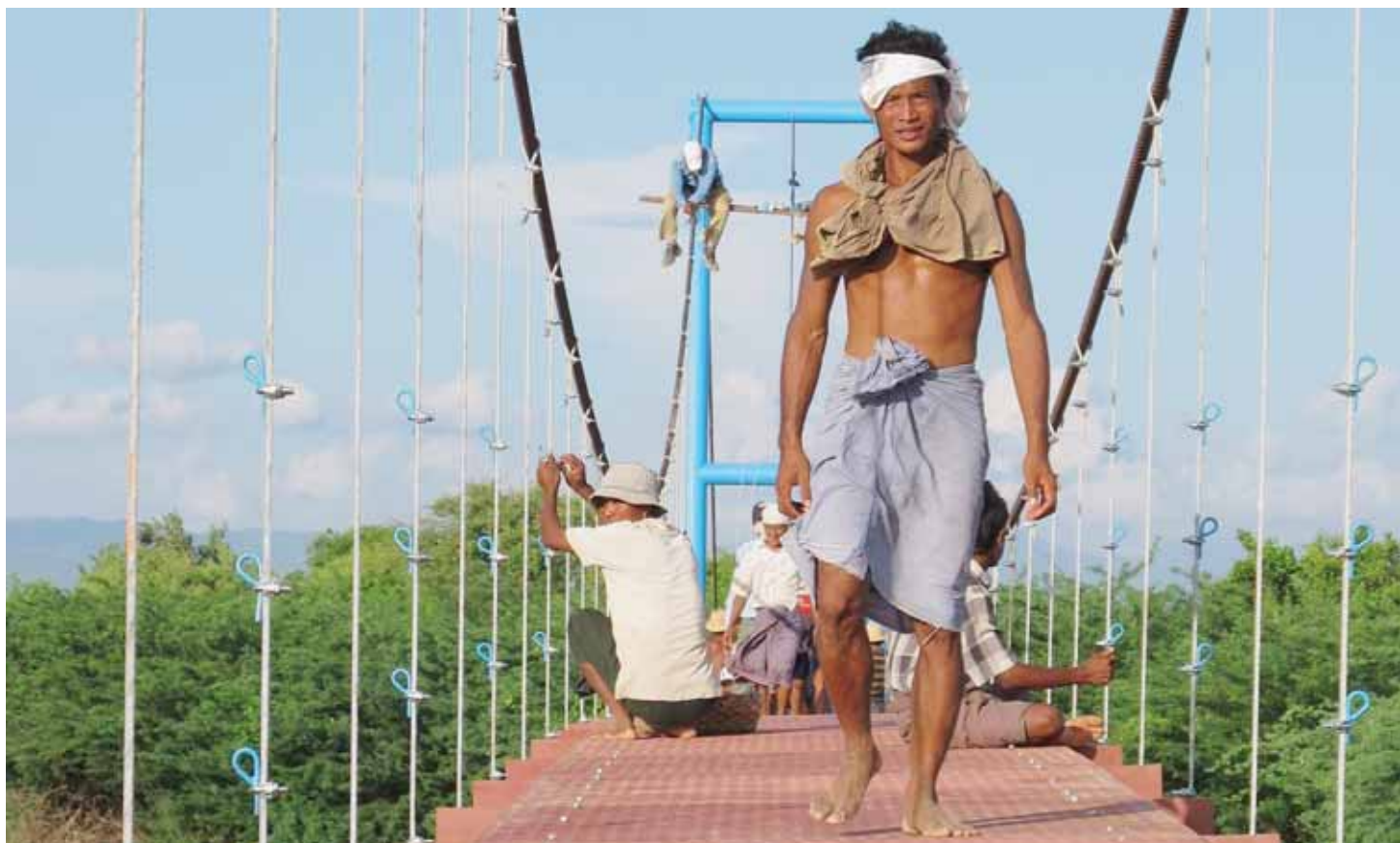
Construction d'un pont en Birmanie. A l'arrière-plan et en hauteur, Toni Rüttimann en plein travail de haubanage. Les boucles bleues reçoivent ensuite des câbles de petite section pour faire office de garde-corps. Ces derniers sont parfois en grillage. SP - TONI RÜTTIMANN POUR TOUTES LES PHOTOS
