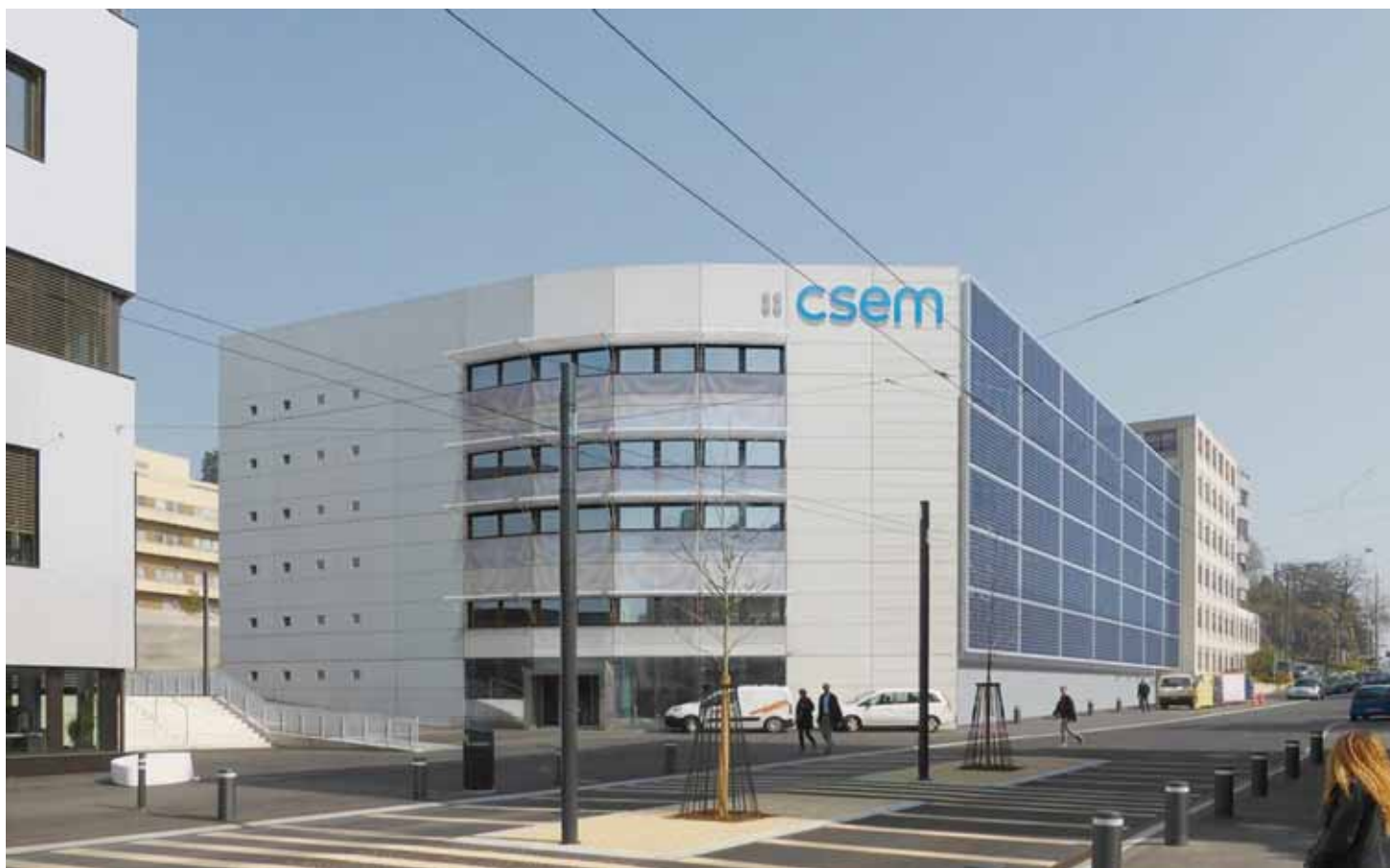
Composé de 210 panneaux, le mur solaire conçu par le bureau Geninasca-Delefortie sera installé au printemps 2015. SP-GDARCHILCH
