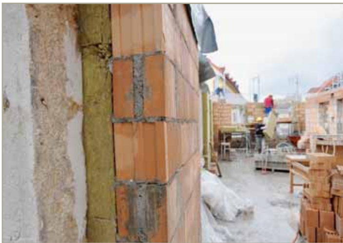
Une opération qui va bien au-delà que le fait de coller un matériau isolant sur un mur. RICHARD LEUENBERGER
