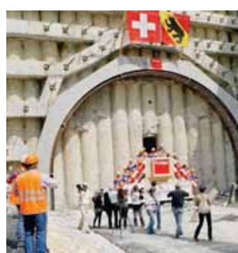
La lumière passe désormais à travers le tunnel entre Pontenet et Loveresse. OLIVIER GRESSET
