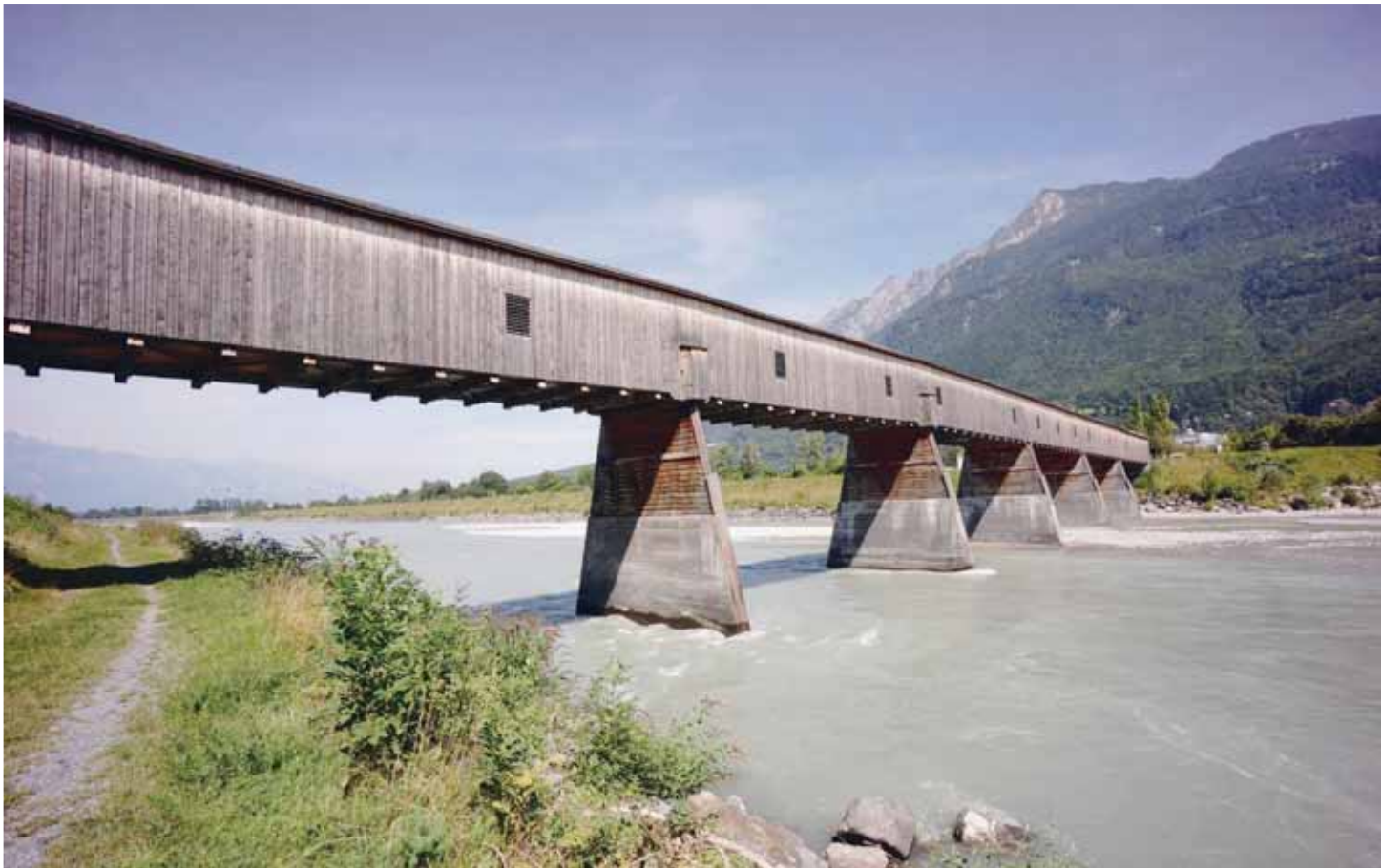
L'impressionnant pont qui relie Sevelen (SG) et Vaduz (FL) avec son toit taviillonné et ses 135 mètres de long reste le dernier survivant des treize qui furent construits dans le Rheintal entre 1867 et 1928. CLAUDE QUARTIER
