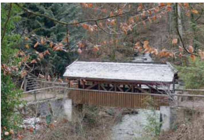
Le petit pont de la Sandoleyre se situe dans l'arboretum d'Aubonne (VD), sa construction date de 1996. CLAUDE QUARTIER
