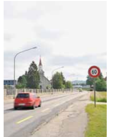
La RC 1320 avant les travaux il y a deux ans. ARCHIVES CHRISTIAN GALLEY
