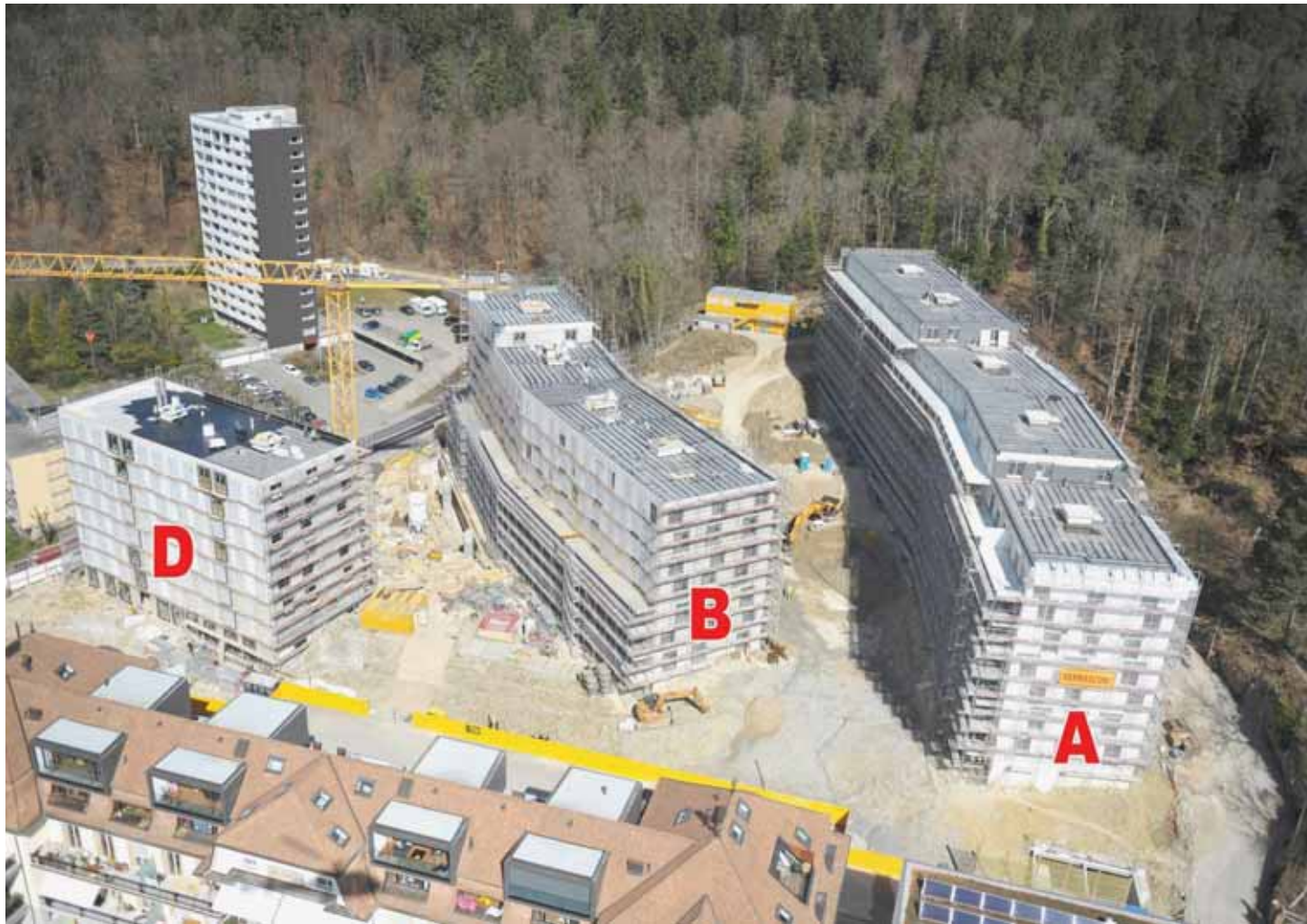
Cent personnes œuvrent quotidiennement sur le chantier des Cadolles, sur le site de l'ancien hôpital de Neuchâtel. Les 21 appartements subventionnés se trouveront dans la partie nord du bâtiment A. La crèche de la Ville au rez-de-chaussée du bâtiment D. SP-ENNIO BETTINELLI
