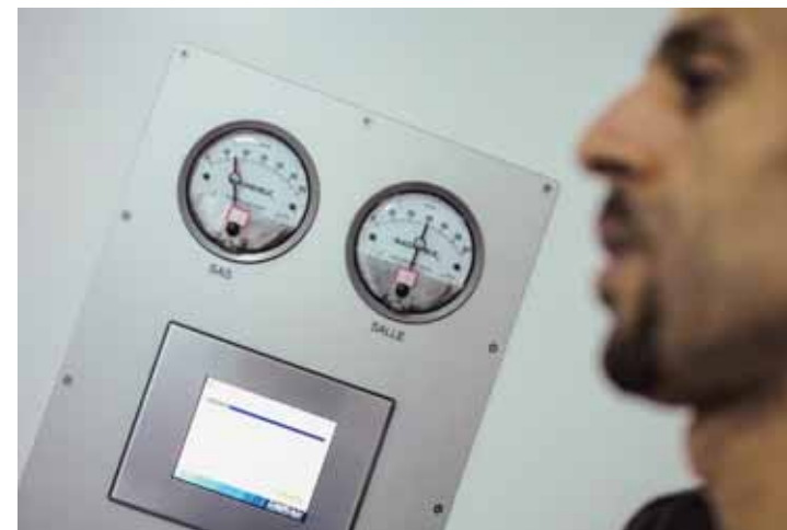
Nicolas Frein enfille ses surchaussures, sous l'œil d'Imad Bahou. Ce dernier vérifie la pression de l'air dans le sas d'entrée de la salle blanche.
