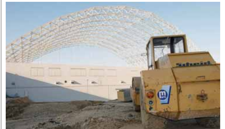
La halle d'excavation a été déplacée sur la partie nord et est désormais opérationnelle. BCI BETRIEBS-AG
