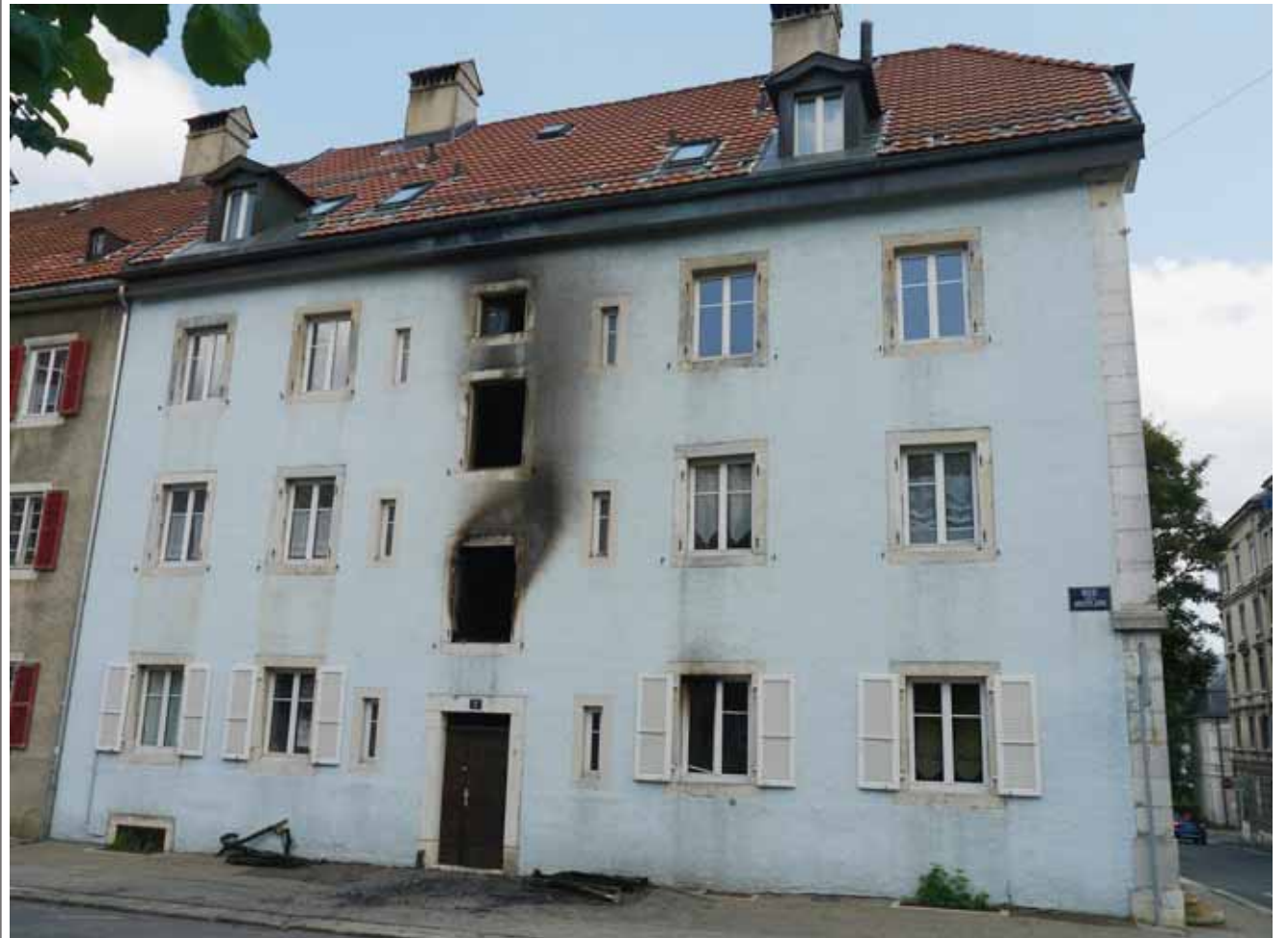
Le 2 de la rue des Moulins quelques heures après l'extinction du sinistre. JÉRÔME BERNHARD
