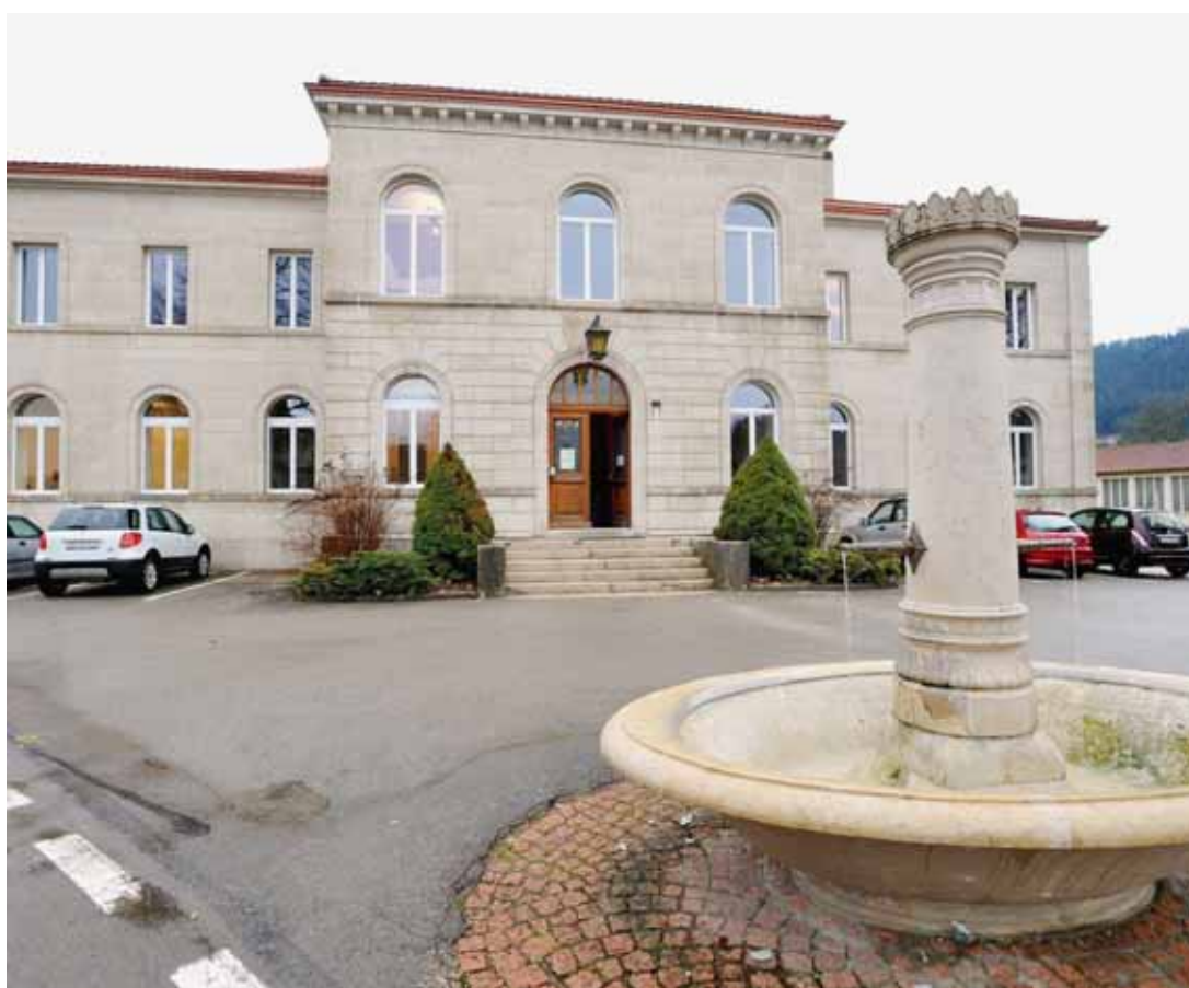
Le 2 de la rue des Collèges, à Couvet, siège du dicastère de l'économie, des finances et de l'intégration sociale. ARCHIVES RICHARD LEUENBERGER
