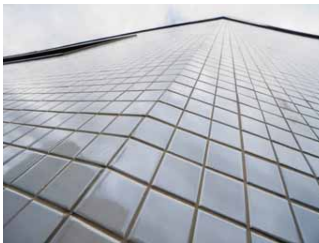
LE CARRELAGE EN FAÇADE Il y a plus de 750 000 éléments! Les modules en céramique de 5 cm x 5 cm évoquent, en façade, des microsystèmes mis bout à bout. Leur coloration a été créée spécialement pour Microcity. PHOTOS CHRISTIAN GALLEY
