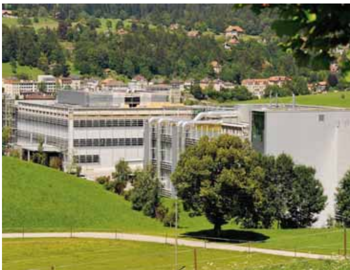
L'extension de la zone économique des Saignoles, ici Johnson & Johnson, implique la construction d'une route provisoire. ARCHIVES R. LEUENBERGER
