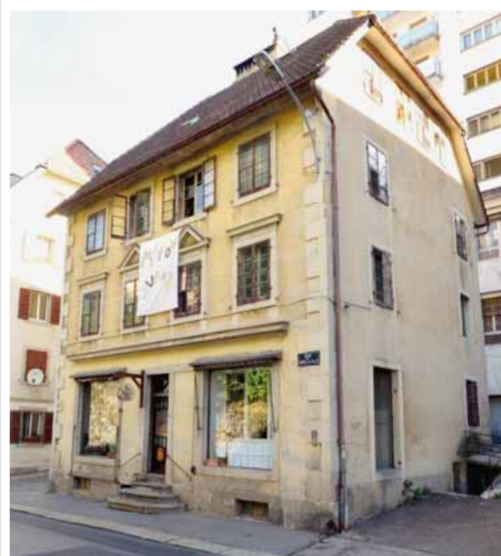
L'immeuble Hôtel-de-Ville 21 retrouvera son vrai propriétaire à fin septembre, qui y referra des appartements.. RICHARD LEUENBERGER
