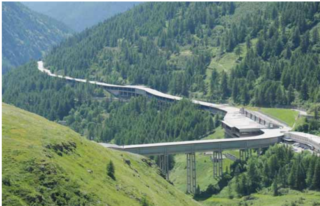
Le tunnel fait désormais partie du paysage. S'il célèbre ses 50 ans, sa genèse remonte aux années 1930. CHRISTIAN HOFMANN
