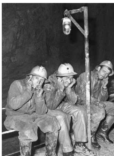
25 mai 1960 Construction du tunnel du Grand-Saint-Bernard: des ouvriers se bouchent les oreilles avant un dynamitage.
