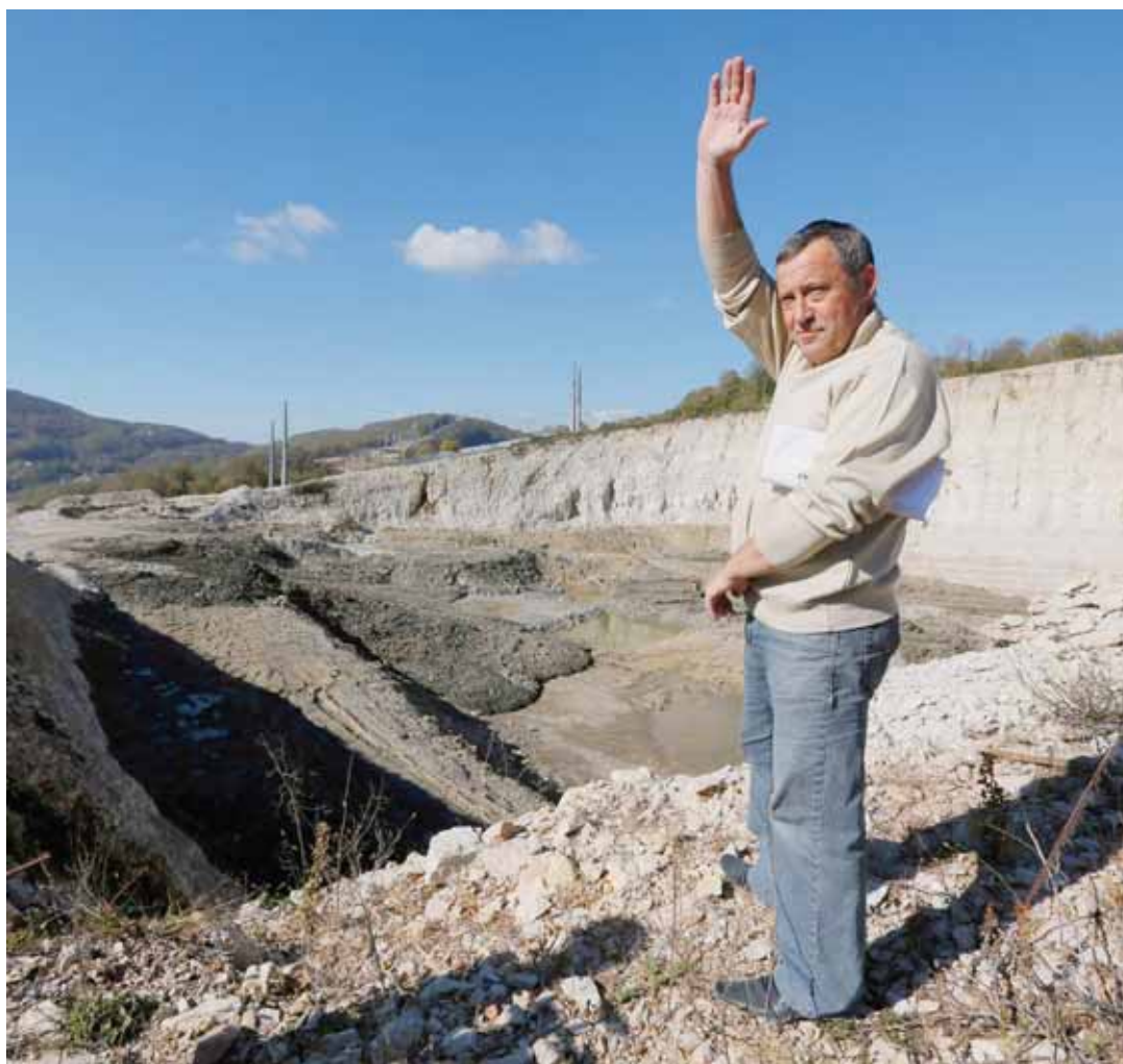
Un responsable d'un village du Caucase salue le photographe devant un des nombreux chantiers encore ouverts à 100 jours des JO d'hiver de Sotchi. KEYSTONE
