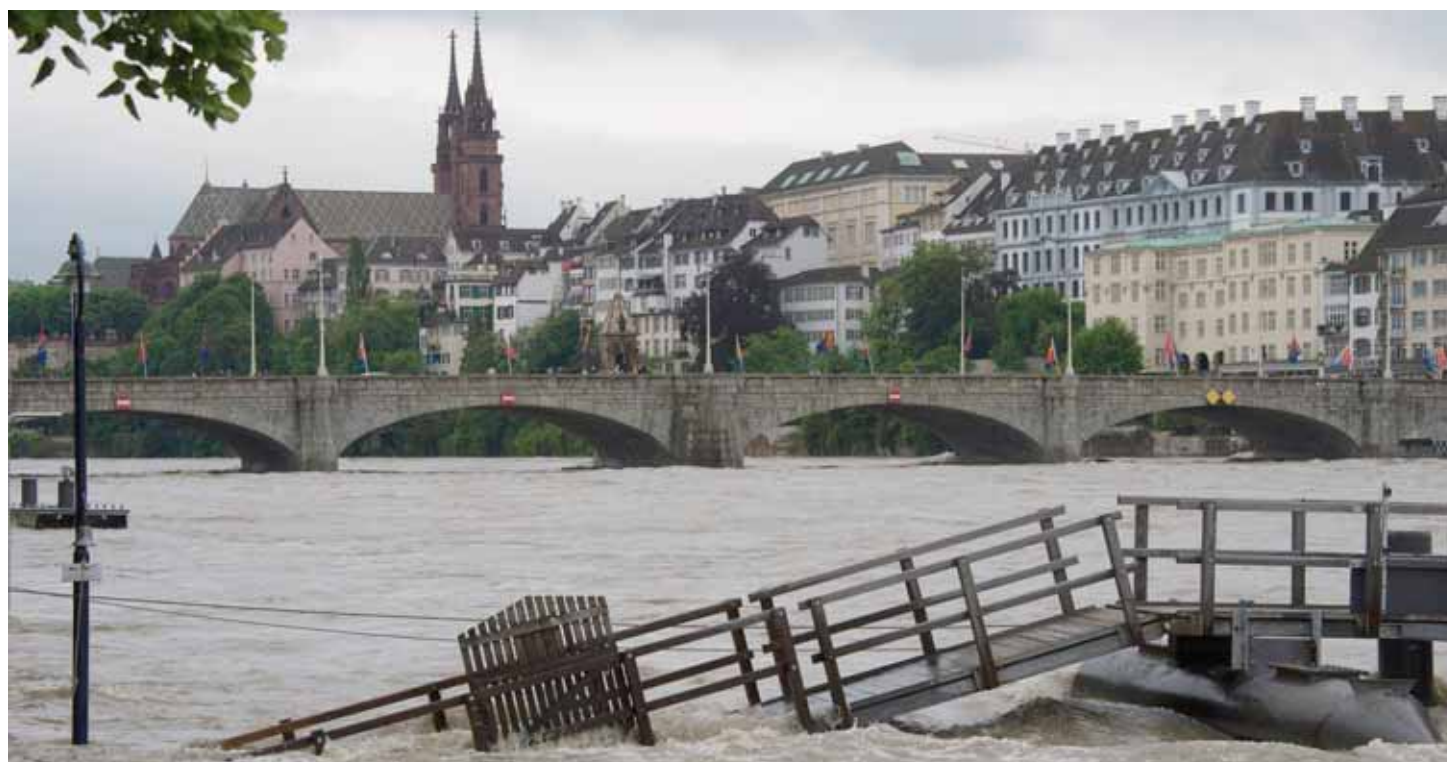
Le Rhin est sorti de son lit et a détruit la passerelle d'un bac dans la nuit de samedi à hier dans la ville de Bâle. KEYSTONE
