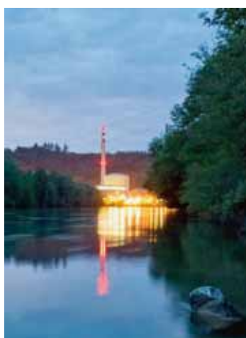
Des sondes de mesures seront plongées dans l'Aar pour mesurer le taux de radioactivité de l'eau en continu. KEYSTONE
