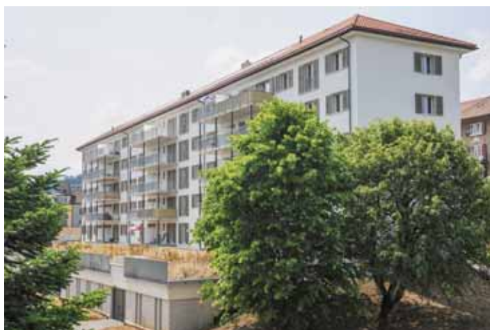
De nombreux immeubles ont été rénovés ou vont l'être, comme ici à la rue Boucle-de-Cydalise 19-21-23 à La Chaux-de-Fonds. C. GALLEY
