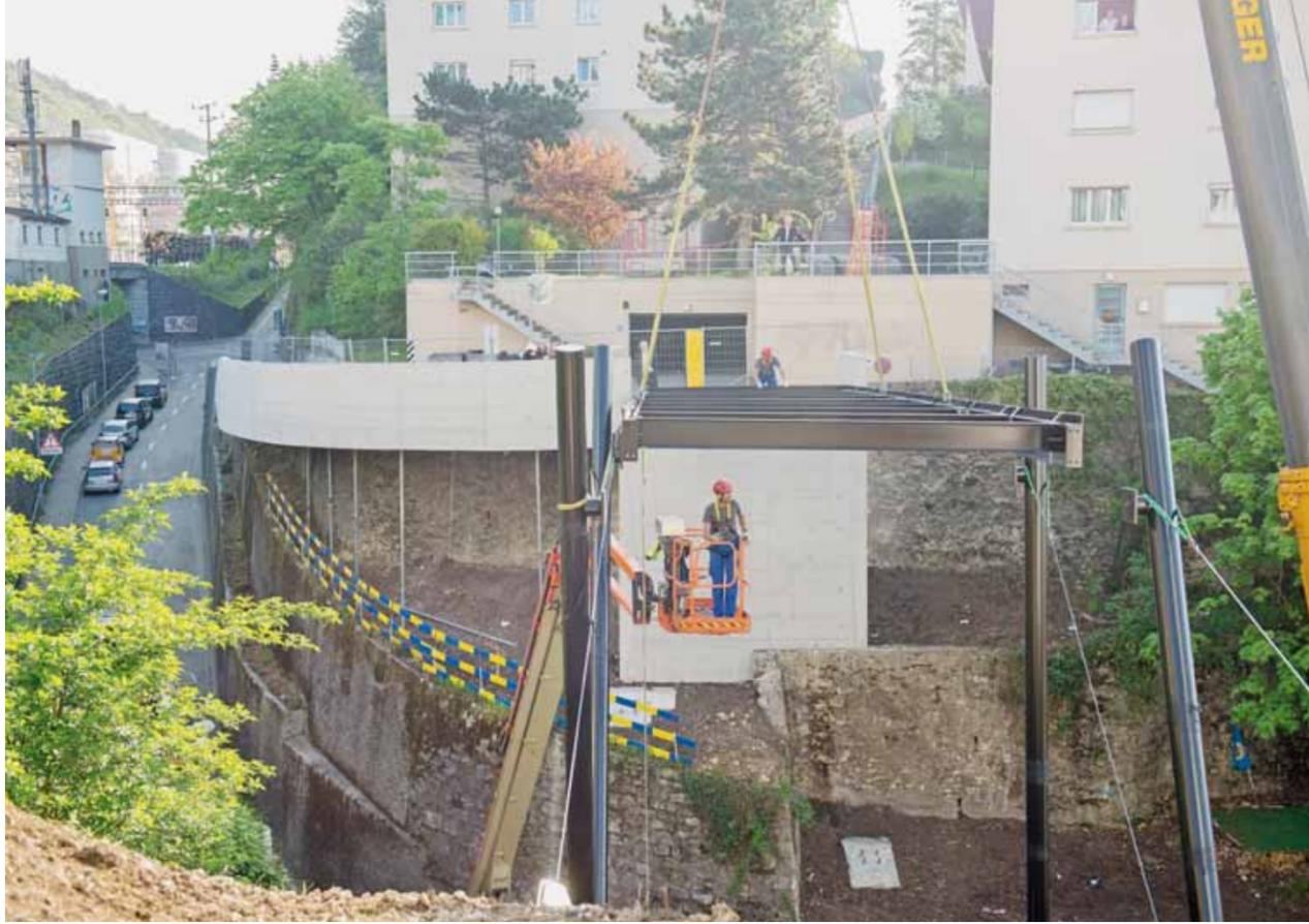
Fabriquées par une entreprise basée à Bulle, les deux structures métalliques pèsent respectivement huit et neuf tonnes, pour une largeur de 4m40 et une longueur d'une vingtaine de mètres chacune. DAVID MARCHON
