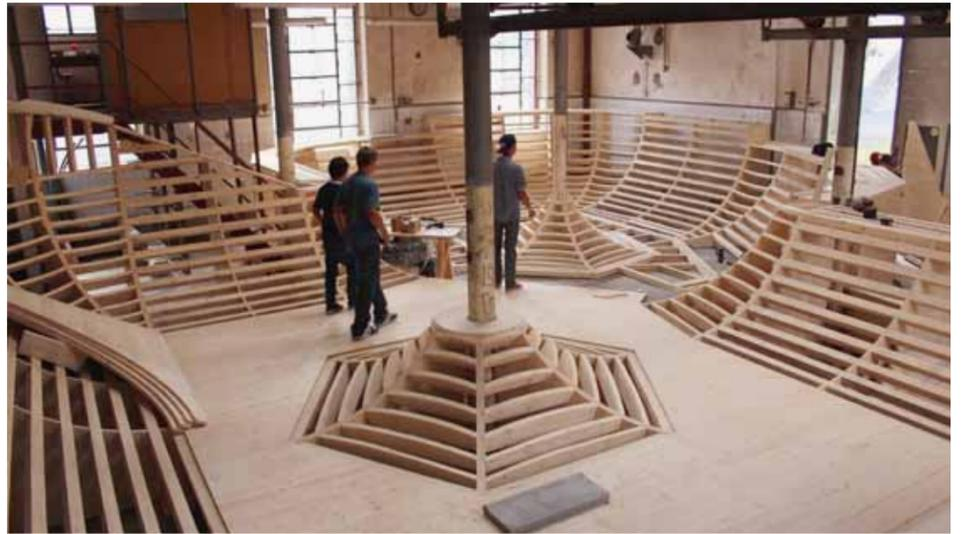
Pose du placage en bouleau sur les éléments en sapin. SP
