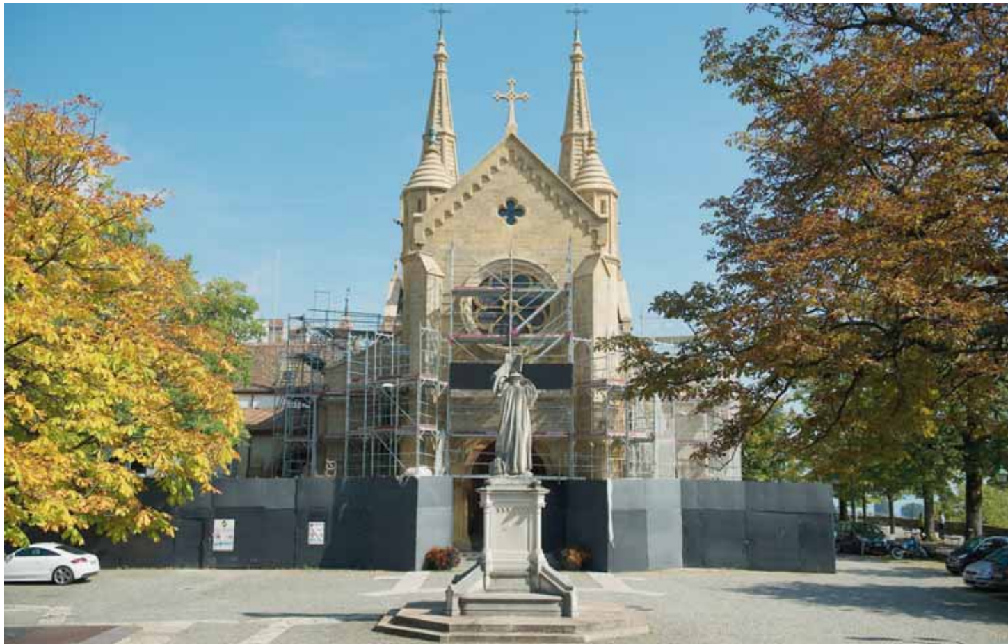
D'ici mi-novembre, les échafaudages pourraient disparaître. Les barricades devraient, elles, faire place nette d'ici la fin de l'année. DAVID MARCHON
