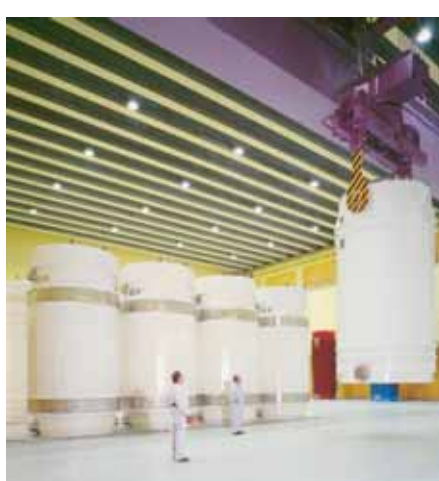
Halle pour déchets hautement radioactifs. KEYSTONE
