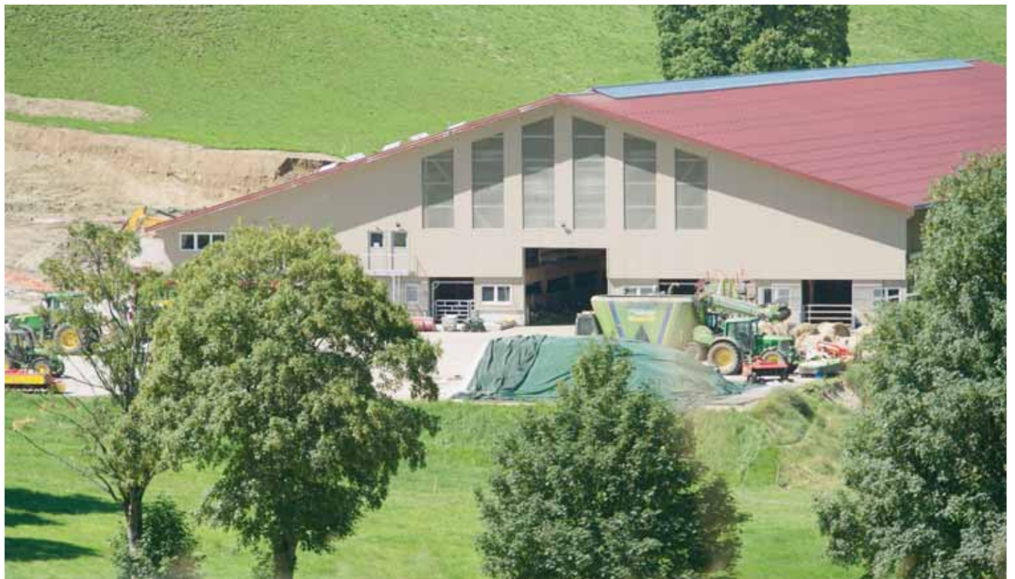
D'importants travaux sur le domaine de la famille Menoud à Môtiers ont été stoppés par la commune de Val-de-Travers et le Département du développement territorial et de l'environnement le 18 juillet dernier parce qu'ils ne sont pas conformes aux plans déposés. DAVID MARCHON
