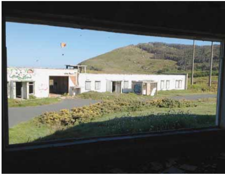
Les bâtiments qui servaient de hangar à bateaux et de garage. CONTESSA PIÑON
