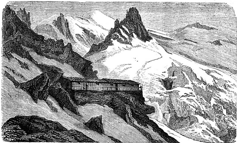
Vue générale du chalet des Grands-Mulets
