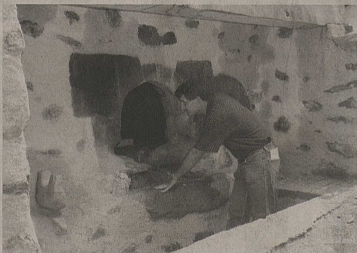
André Ançay supervise les travaux de rénovation du four qui touchent actuellement à leur fin.
