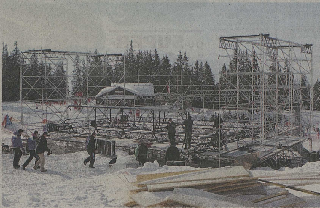
La scène en construction à l'intermédiaire de Grand Signal jeudi matin.
