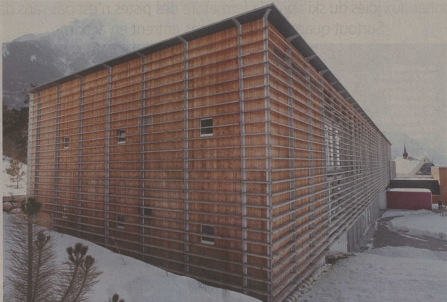
Le nouveau corps de bâtiments, présenté hier, relie l'ancien collège au nouveau.
