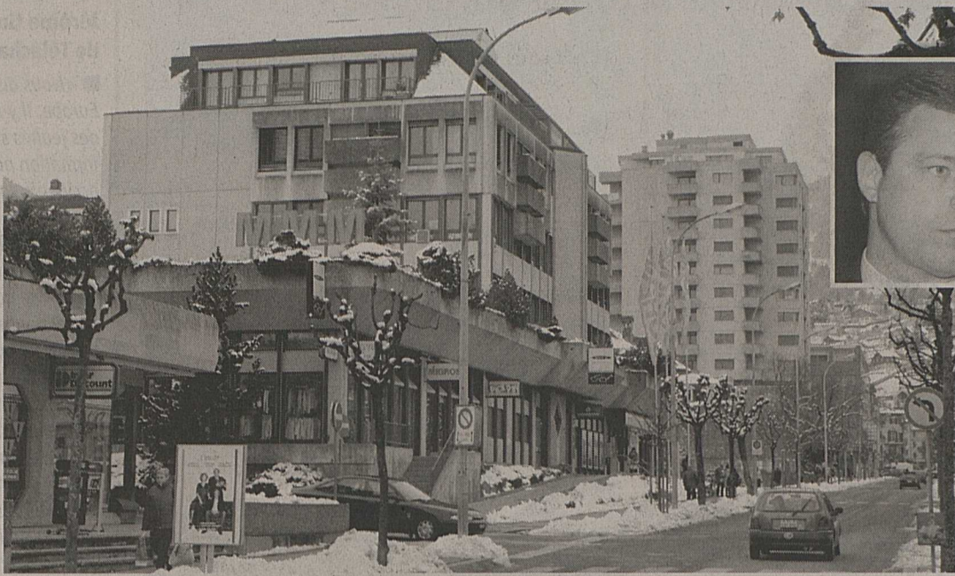
Bruno Inderkummen se dit fortement convaincu du succès de l'agrandissement du centre de la Verrerie, prévu entre le 3M et la tour du Market.
