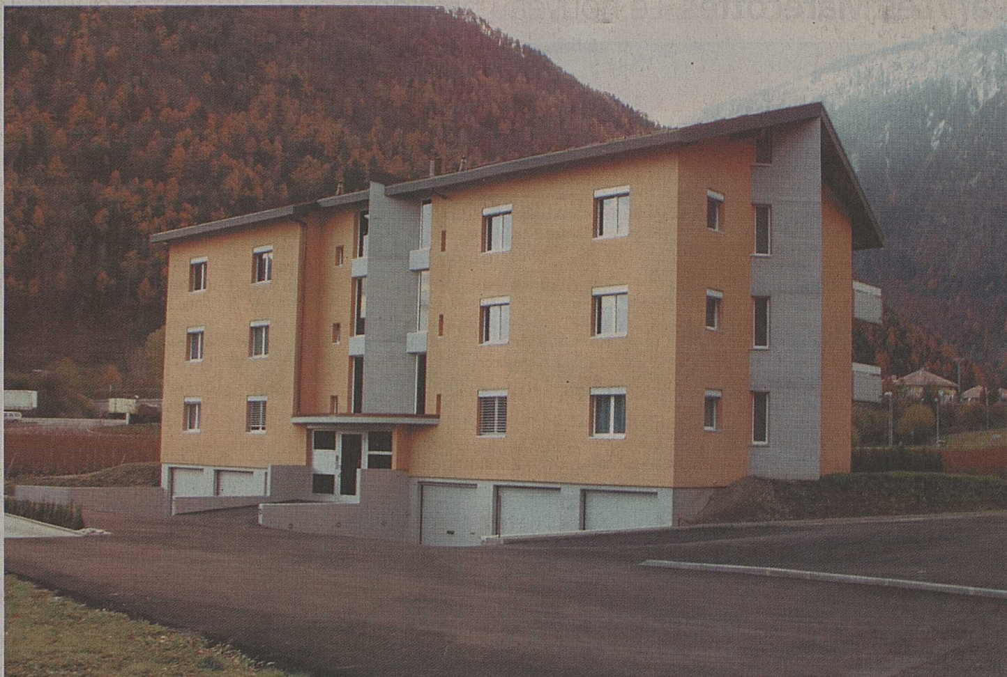
Ce petit bâtiment présente un indice d'utilisation au sol de 0,546 alors qu'il n'aurait pas dû dépasser le 0,4.
