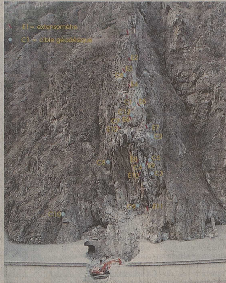
Après l'effondrement d'un compartiment rocheux de 600 m 3 sur la galerie de la Monnaie aux Trappistes, des extensomètres ont été installés autour de la niche d'arrachement. ldd
