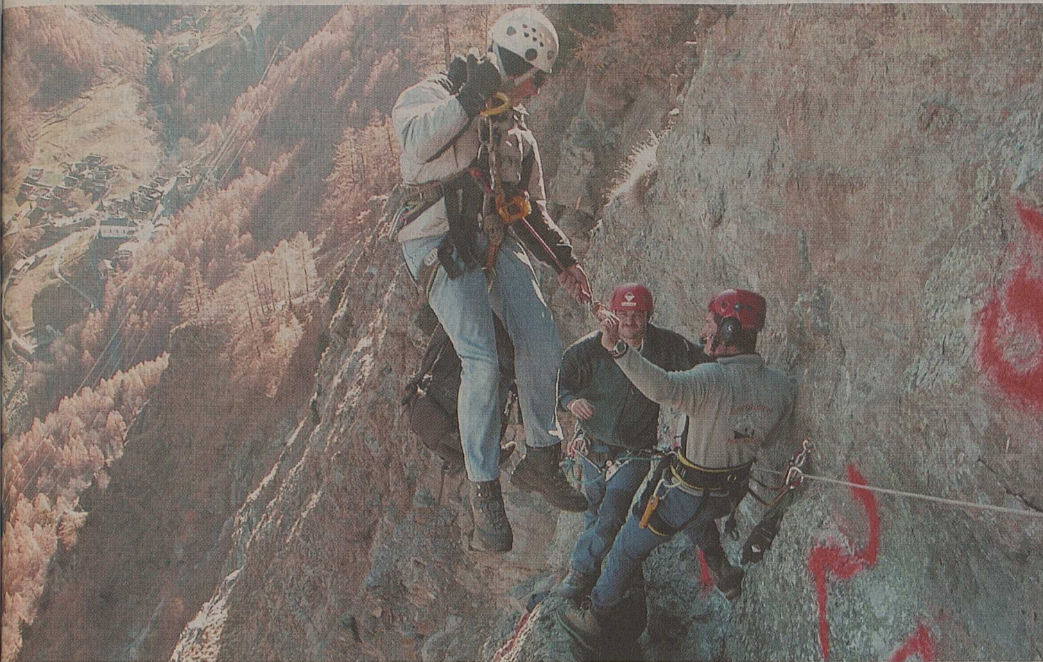
Deibfels, les mineurs et foreurs ont dû intervenir dans une paroi difficile d'accès. ldd
