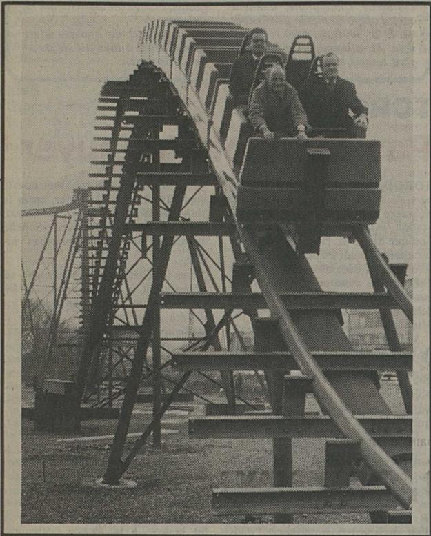
Une vue du train, comprenant sept wagons de quatre places, circulant par gravitation à des pointes de 80-90 km/h.
