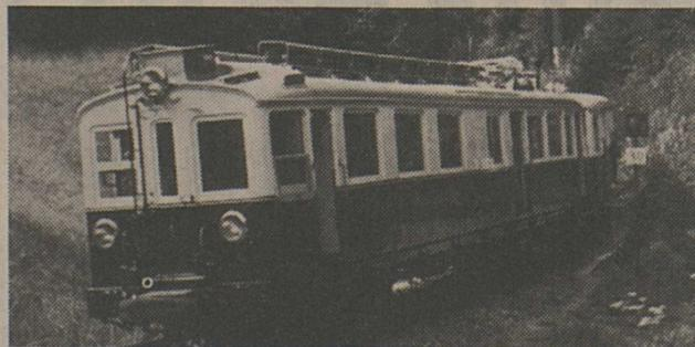
Cette automotrice (photographiée en gare des Marécottes) avec la voiture à voyageurs, mise en service au début de l'exploitation de la ligne, pouvaient transporter 80 passagers assis. Le matériel roulant de 1957 offre 120 places assises plus un compartiment à bagages. La nouvelle composition comprendra 164 places assises et 118 places debout.
