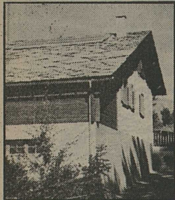
Cette maison de Lens : de l'eau chaude par le soleil.
