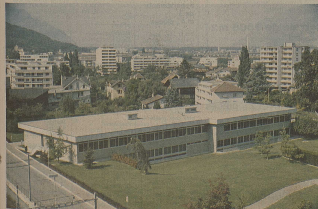
Au carrefour de la rue de l'Industrie, de la rue des Produits et du passage à niveau CFF, l'entrée principale du trafic marchandise avec une composition du «Tonkin». A droite, le premier bâtiment administratif du début du siècle. La photo de gauche: au premier plan, l'école d'industrie où les apprentis de Ciba suivent les cours professionnels et où se donnent également les cours de recyclage. Au fond, le quartier périphérique dit de «Sous-Gare», qui a pris un développement considérable ces dix dernières années.
