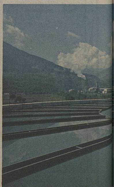
L'usine est une grande consommatrice d'eau dans cette installation. L'eau sert au refroidissement directement à la production chimique.
