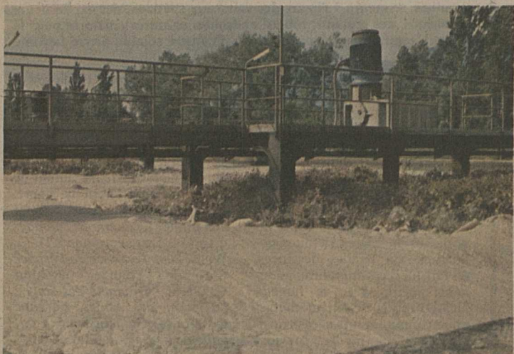
A la station d'épuration. Ces bassins dits «biologiques» accélèrent le processus naturel d'épuration par l'introduction d'air dans l'eau.
