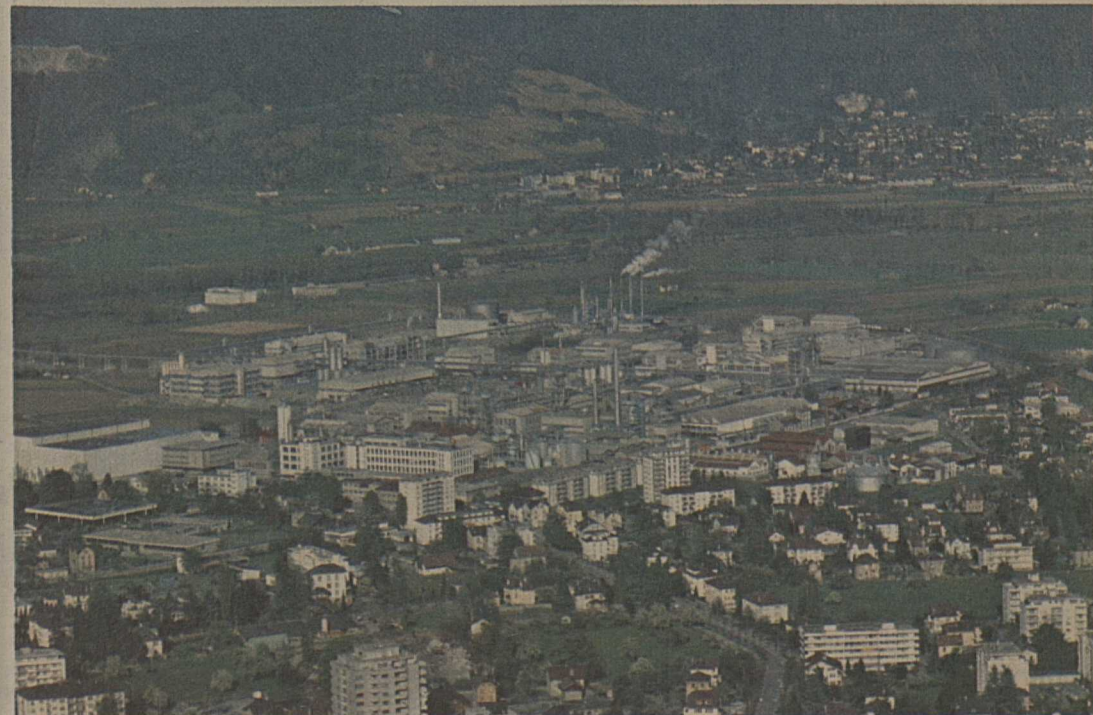
Vue aérienne de l'usine. L'enceinte de Ciba-Geigy englobe un peu plus de 600 000 m 2 . Dans ce chiffre ne sont pas compris les terrains de réserve maintenus en exploitation agricole. Photos Ciba-Geigy
