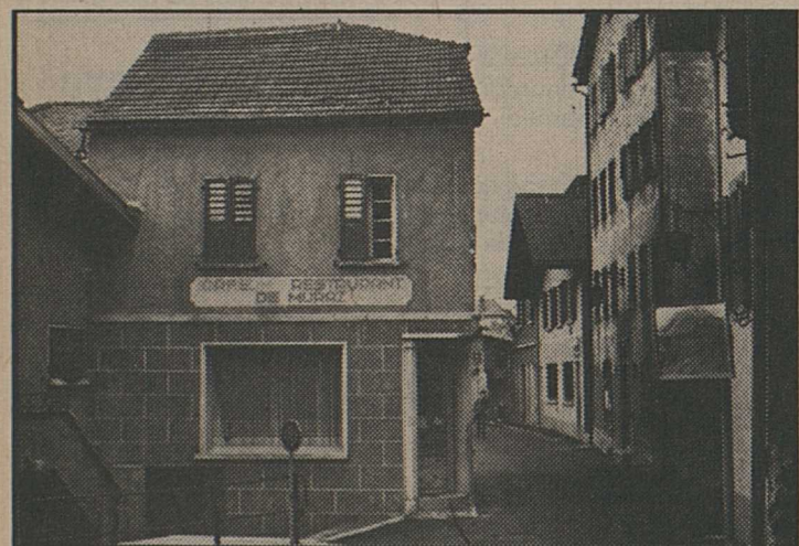
Avant la démolition.
