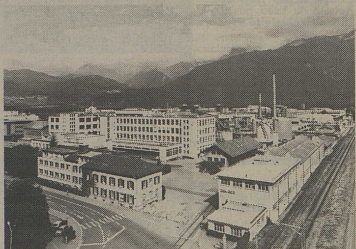
Vue partielle de l'entreprise Ciba-Geigy de Monthey avec l'entrée de la voie industrielle et, à droite, la ligne du Tonkin.
