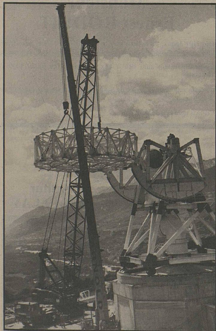
La mise en place de la parabole.
