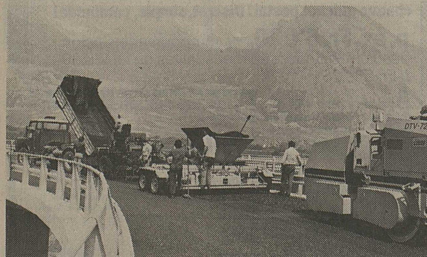
Pose d'un revêtement bitumineux spécial en «Hot Rolled Asphalt» HRA sur le viaduc de Riddes.
