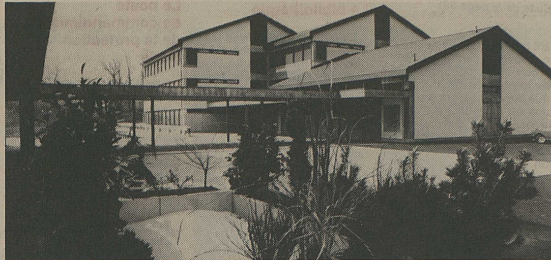
Voici les bâtiments de l'école primaire
