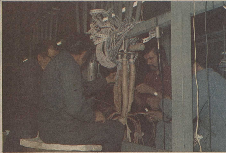
C'était l'été dernier, dans le sous-sol du nouveau central téléphonique. Durant plusieurs mois, des équipes de monteuses spécialisées ont travaillé à la modification de l'entrée des câbles dans le bâtiment ainsi qu'au transfert des lacets reliant les abonnés de Monthey à leur central local. Cette coupure de câbles a été fractionnée sur une période de douze mois et l'on fit transiter les lignes d'abonnés par les nouvelles installations, non encore en service, vers les anciennes toujours en fonction. Un travail de titans... Photos NF
