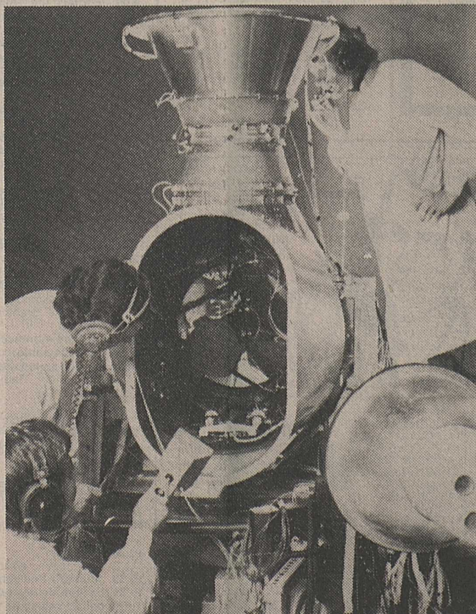
Le radiomètre Meteosat en cours d'intégration chez Matras.
