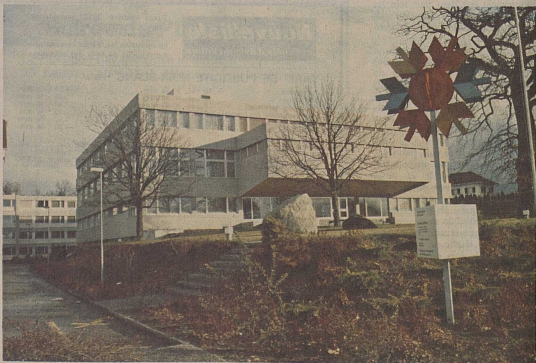
Le principal des nouveaux bâtiments...
