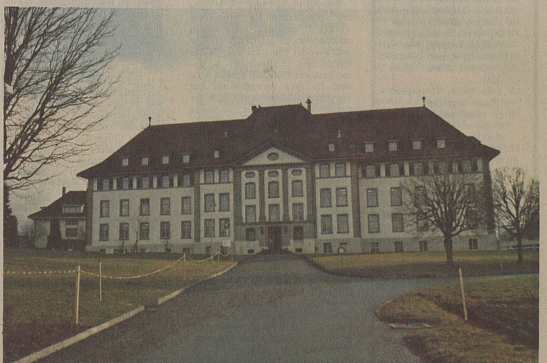
...l'ancien, entièrement rénové, a toujours fière allure.
