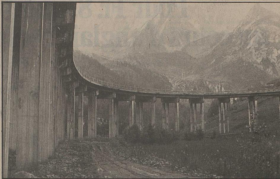
C'est un viaduc comme celui-ci (situé à la sortie du tunnel côté italien) - mais plus haut - qui permettra de traverser le Buthier, après Porosan.
