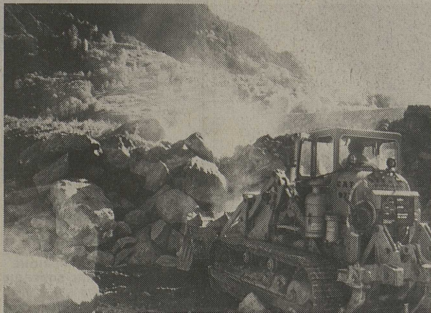
Un trax déménage la digue nord-amont. A l'arrière plan, construite en 1976, la digue sud protégeant le village de Lourtier des avalanches.
