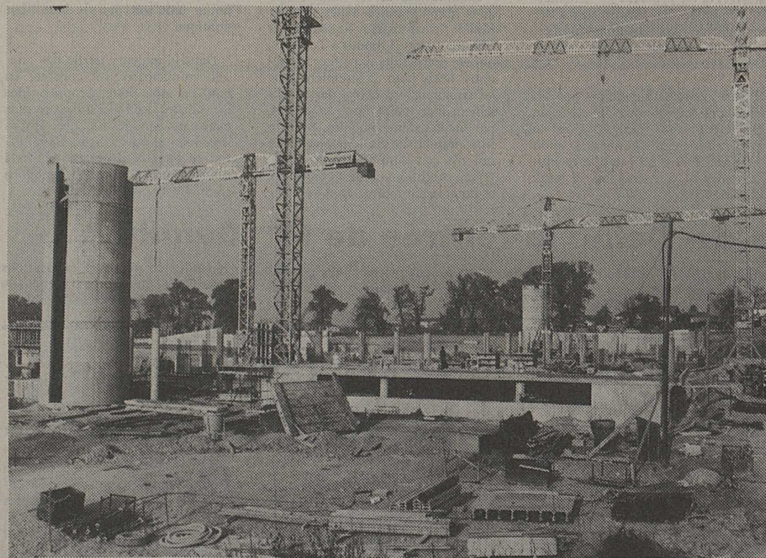
Plus de 250 000 mètres cubes : c'est le volume de terre qu'il aura fallu déplacer dans le cadre de la construction du nouveau palais des expositions de Genève, dont l'ouverture est prévue pour 1981. Quatorze tours gigantesques supporteront l'impressionnante charpente métallique qui pourra abriter une salle de congrès de 2000 places et trois halles de 15 000 mètres carrés chacune qui formeront l'essentiel du bâtiment. Un parking de 2000
