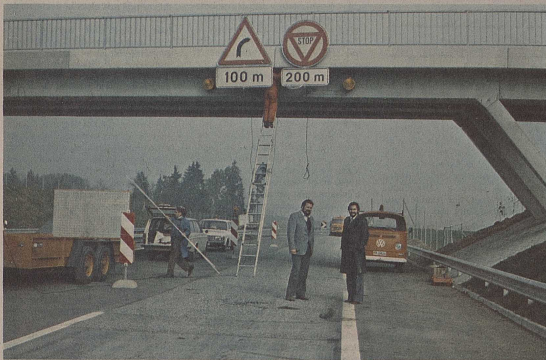
M. Fernand Girod, directeur des travaux (à droite) en compagnie de M. Hayoz, responsable des finitions et signalisations, au départ du nouveau tronçon à Riaz-Vuippens.
