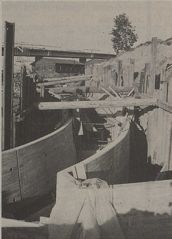
Palplanches, étayage, coffrage et bétonnage des murs pour la correction du ruisseau de la Gibbe, à Semsales.
