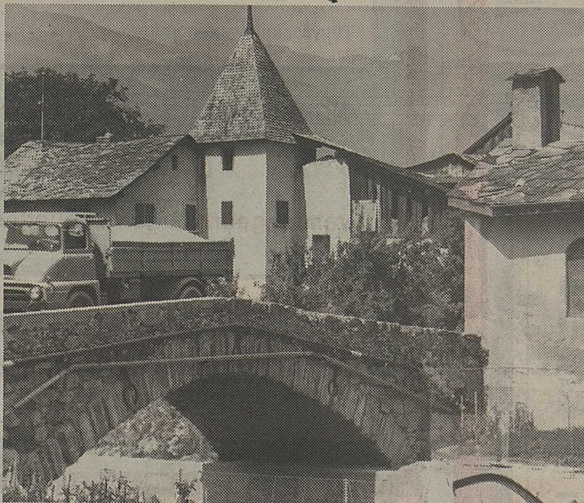
Le pont de pierre de l'époque napoléonienne.
