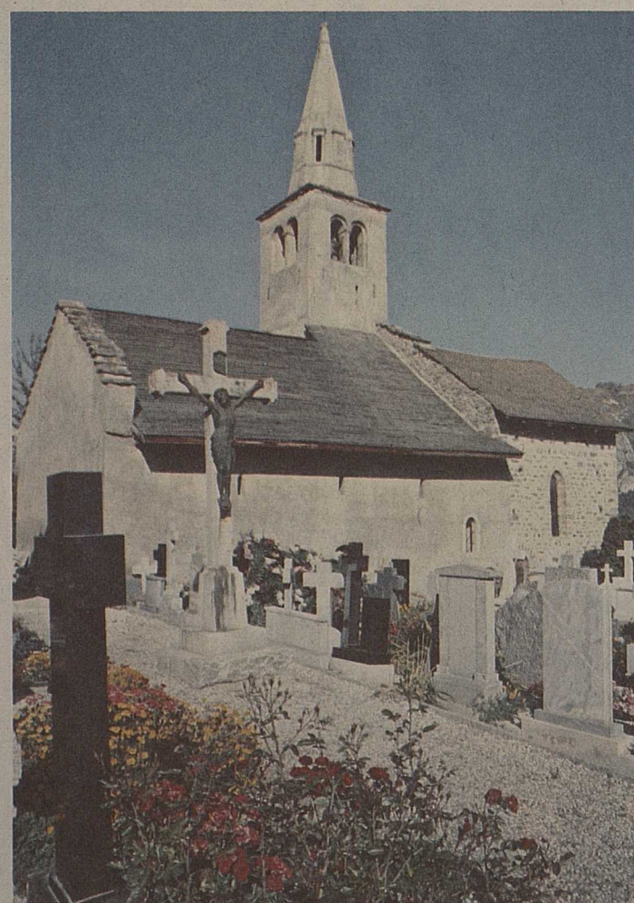
L'église vue de l'extérieur présente clairement ses défauts de vétusté: le toit de madrier est très sérieusement touché. Il en est de même pour le clocheton où l'on constate un effritement avancé.
