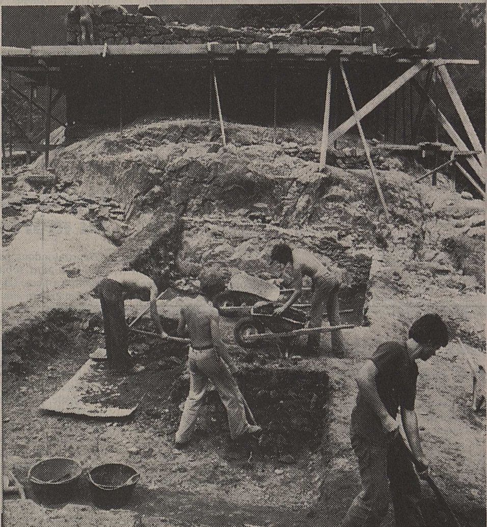
Pour empêcher que la ruine du château fort de «Zwing-Uri», situé au-dessus d'Amsteg, ne se détériore encore davantage sous l'effet des intempéries et conserver ce qui en reste pour la postérité, d'importants travaux de restauration et des fouilles approfondies ont été effectués dans le courant de l'été 1978, avec l'appui financier de l'Union de Banques Suisses. De nombreux apprentis et apprenies de la banque y ont participé bénévolement et avec enthousiasme. Les fouilles archéologiques dans les abords immédiats, l'habitat le plus ancien du canton d'Uri, ont conduit à des découvertes du plus haut intérêt.
