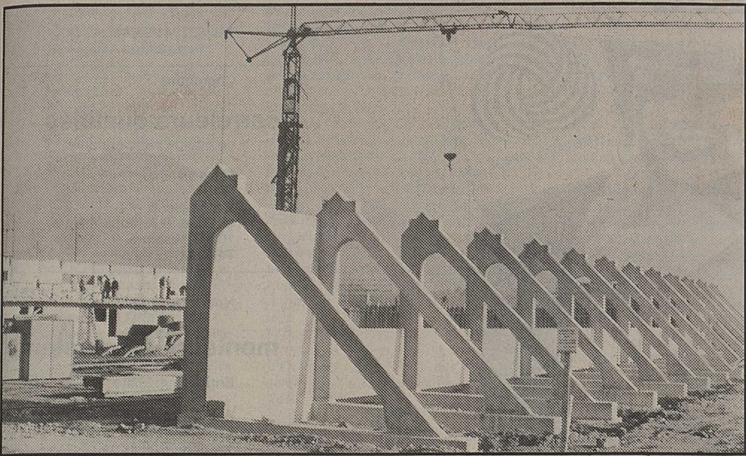
Une vue des treize arcs de béton du côté sud qui supporteront les fermes de la toiture en bois collé. La surface de glace de 30 mètres sur 60 mètres sera formée d'une dalle flottante en béton avec un système d'ancrage particulier étant donné la nature du sol. Coulés dans la dalle, 24 km de tuyaux assureront la fabrication de la glace.
