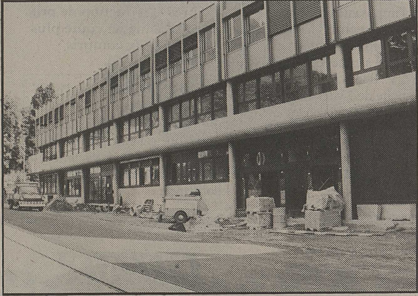
La nouvelle poste à l'allure moderne s'inscrira encore mieux dans son décor actuel une fois les aménagements terminés et le vieux buffet de gare démolit.
