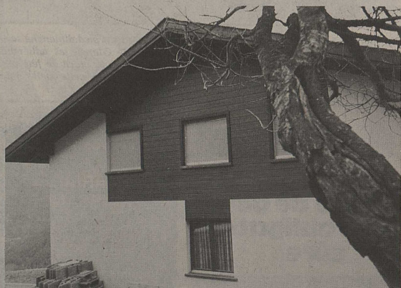
Une construction récente à Törbel. La présence de «Werzalit» donne plus de chaleur, de contraste à la façade.
