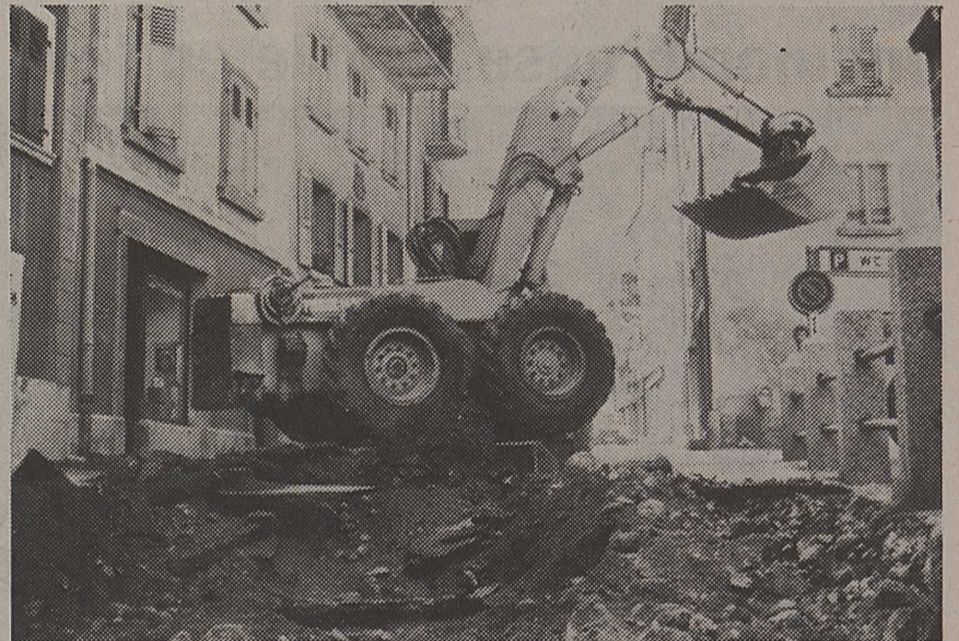
Opération de décapage de la chaussée aux abords de l'église à Orsières.
